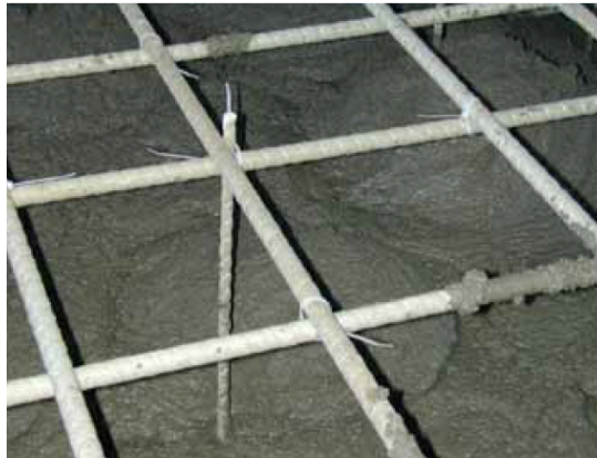
Figur 26 Sammanfogning av armering med plastband
