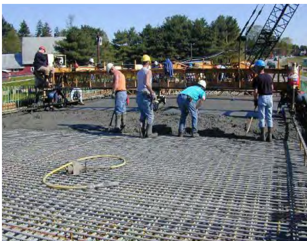
Figur 27 Gjutning av brodäck i Vermont i USA 2002
