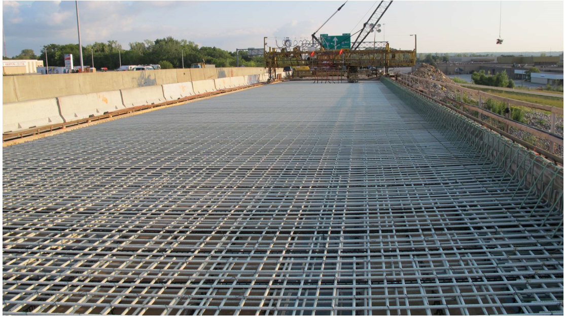
Figur 9 Brodäck armerat med 19 mm GFRP stänger, Kansas City, I-635, USA ( www.aslanfrp.com ).
